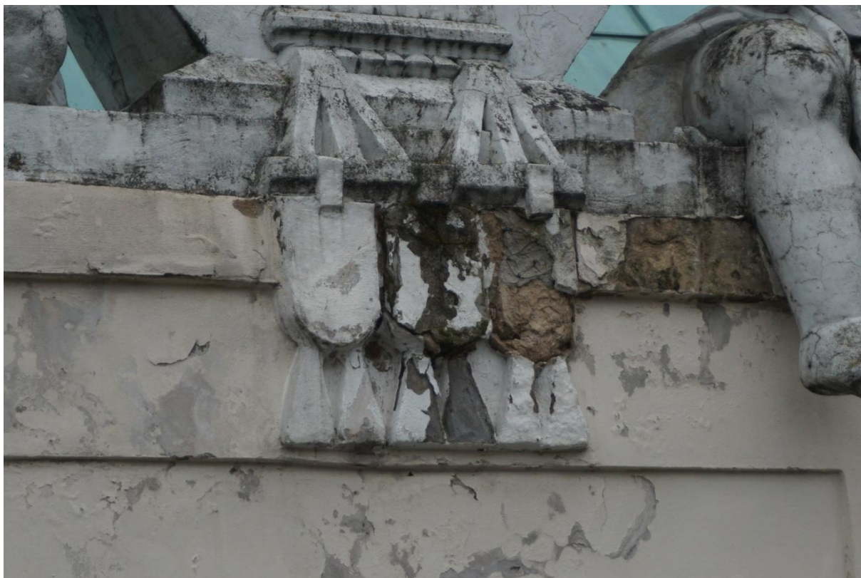
Západní fasáda (zahradní). Detail poškození štukové výzdoby. Havarijní stav.
