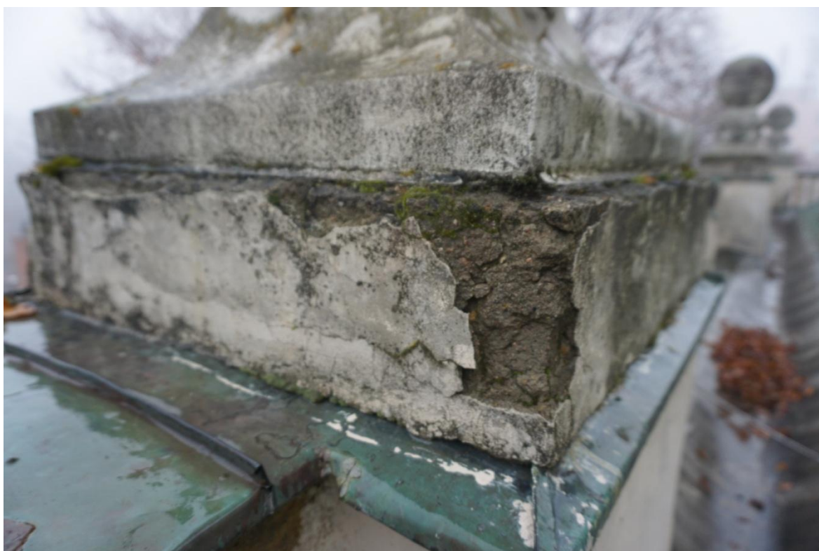
Kulovitě ukončené vázy. Lokálně na několika vazách havarijní stav. Prosakující voda vytéká prasklinami, vytváření sádrovcových výluhů, pod vazou poškozená izolace, hloubkově popraskaný sokl, měděné oplechování.
