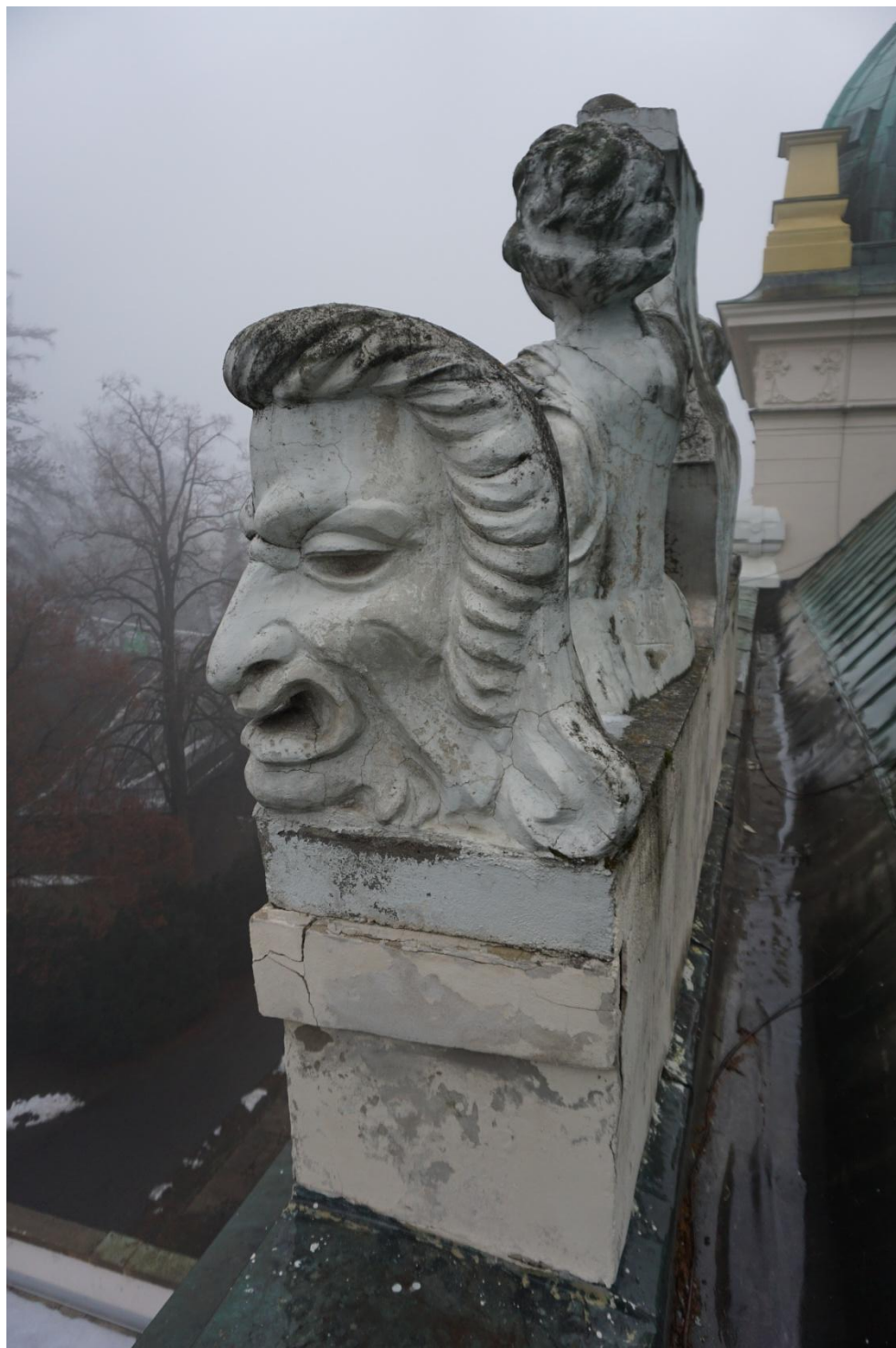
Západní fasáda (zahradní). Detail poškození štukové výzdoby.
