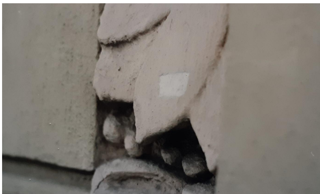
Provedení sond barevnosti fasády Smetanova domu - průčelí.
