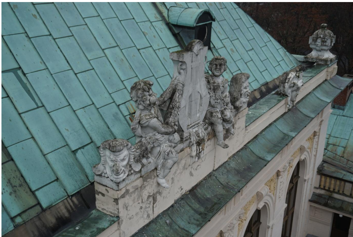
Západní fasáda (zahradní). Detail poškození štukové výzdoby.
