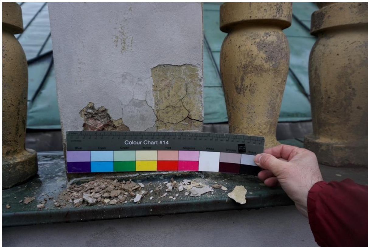
Stratigrafie barevných vrstev fasády – pilíř balustrády. Hlubkové poškození prasklinami.
