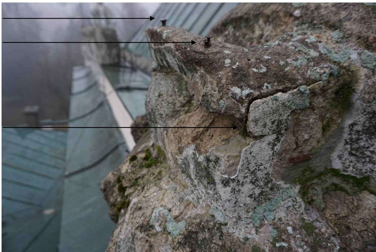
Smetanův Dům v Litomyšli, Jižní fasáda. Detail poškození, rok 2021-22. Obnažená armatura.
