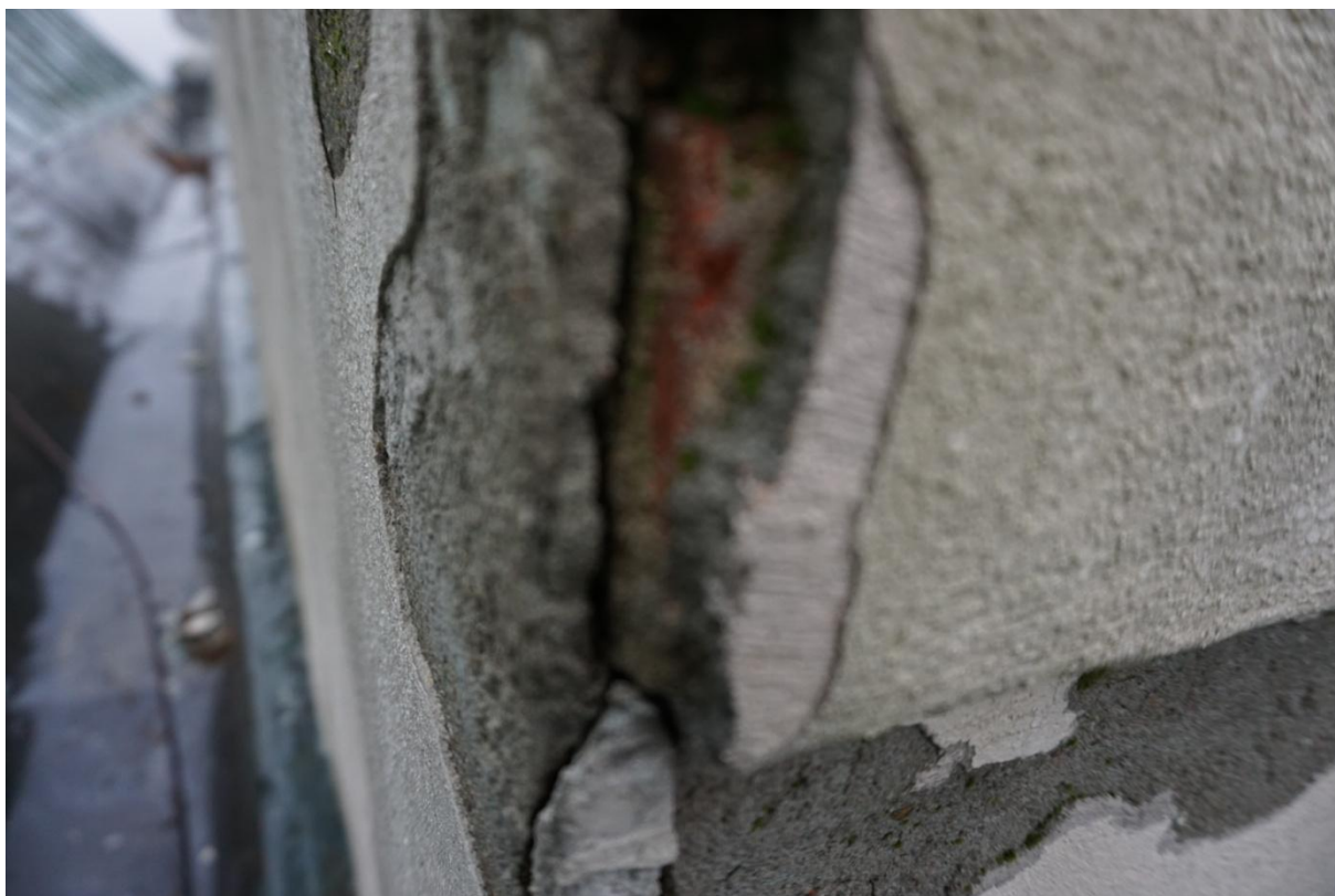
Západní fasáda (zahradní). Detail poškození štukové výzdoby. Cihlová konstrukce.
