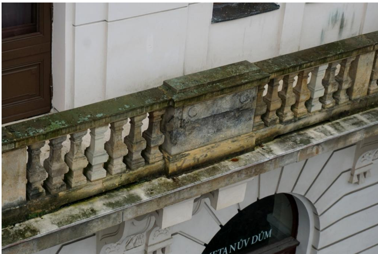
Východní fasáda. Pískovcová balustráda balkonu včetně parapetů a pilířů nad vstupem do Smetanova Domu.
