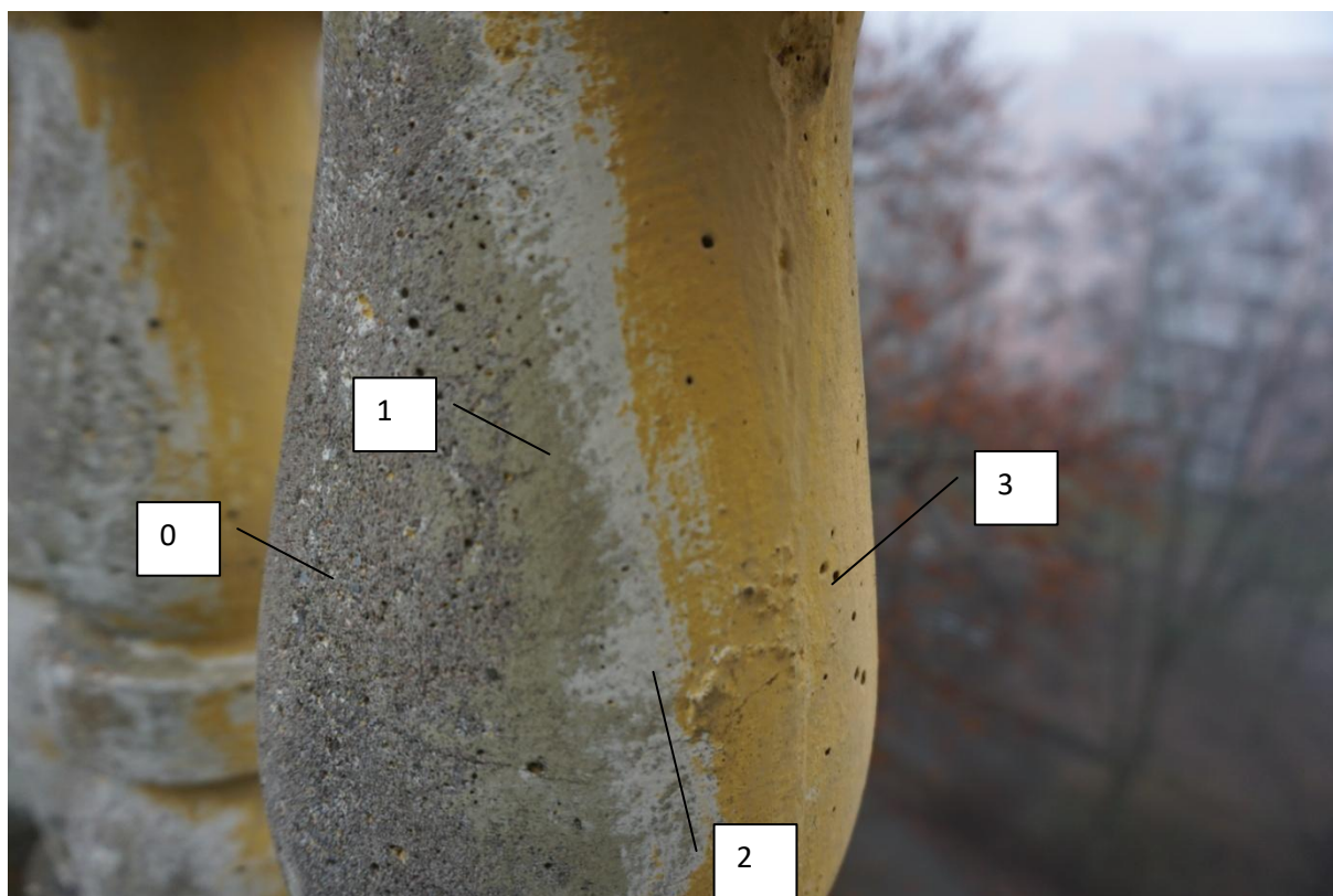
Posloupnost barevných vrstev na balustrádových kuželkách.
