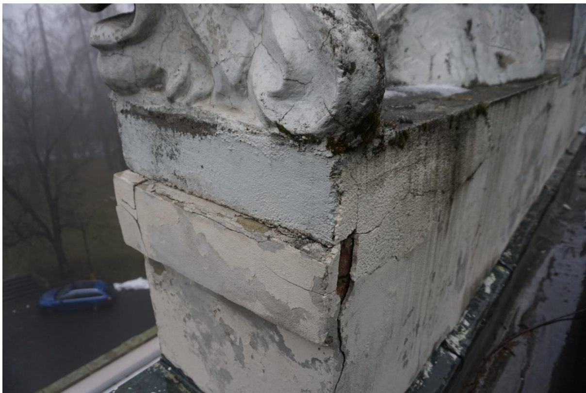
Západní fasáda (zahradní). Detail poškození štukové výzdoby.
