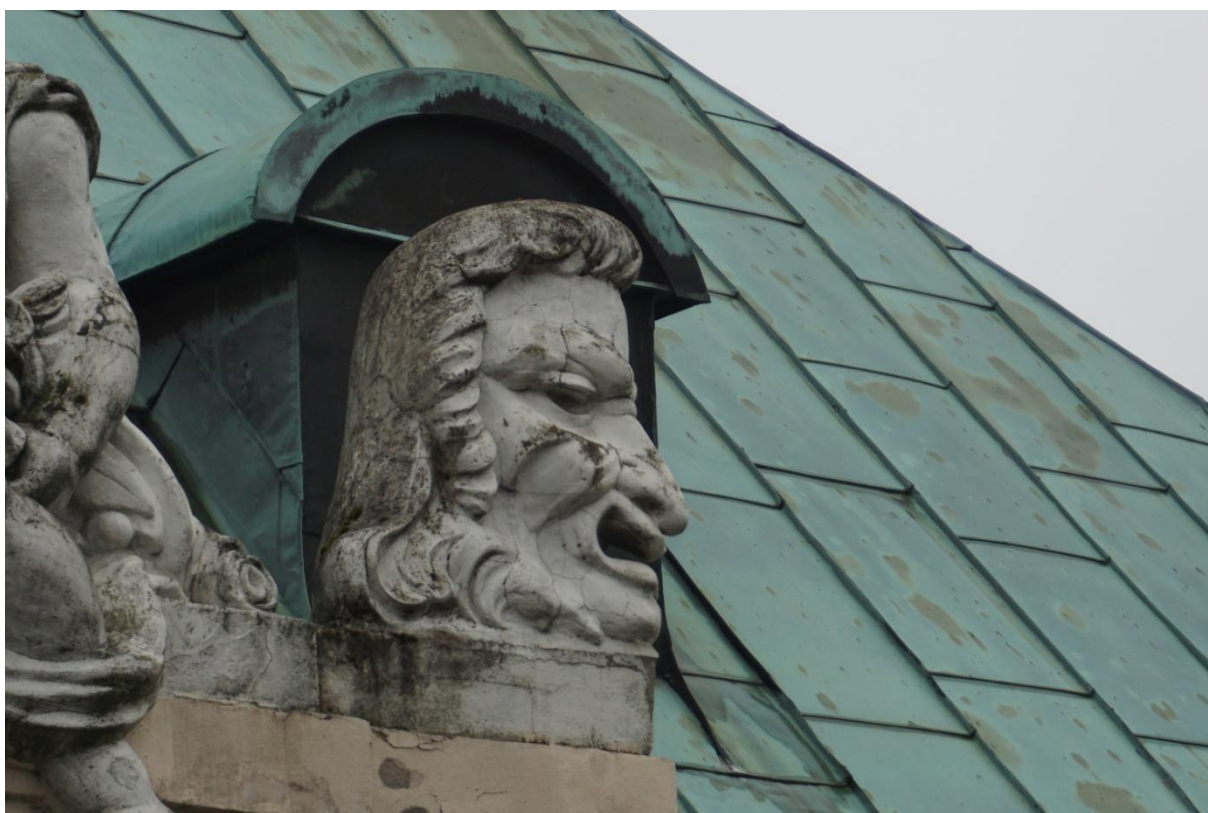
Západní fasáda (zahradní). Detail poškození štukové výzdoby. Dramatická maska.
