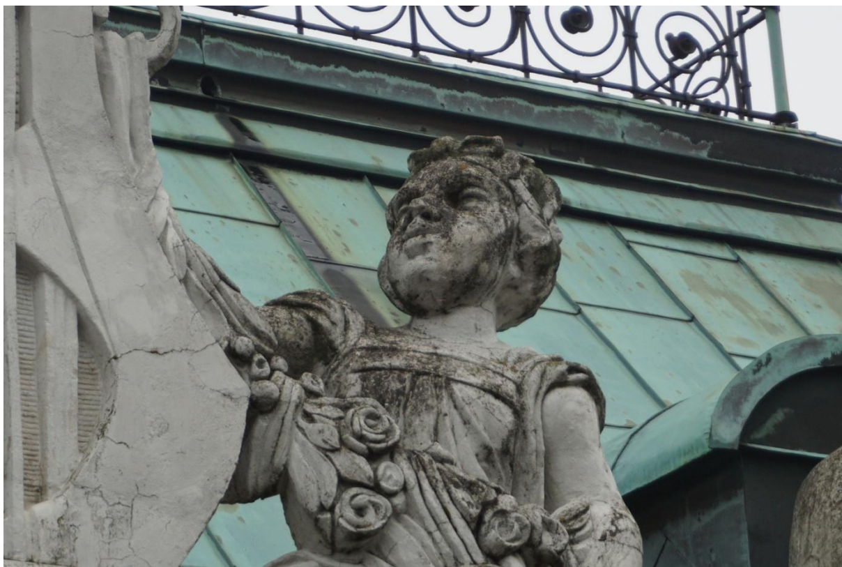
Západní fasáda (zahradní). Detail poškození štukové výzdoby.
