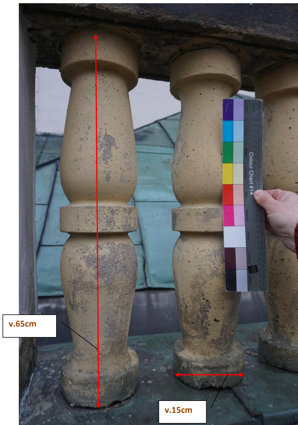
Betonová kuželka s barevným rejstříkem. Rozměry betonové kuželky š.15cm x v.65cm
