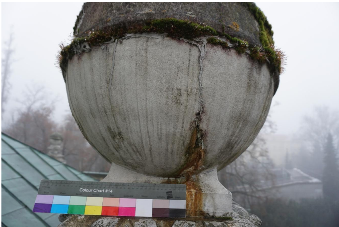
Provizorně opravené praskliny silikonovým tmelem. Biologické depozity ve spár.
