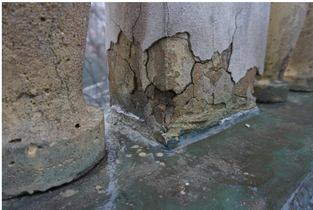
Pod vrstvou cementové malty rozpraskaná hmota pilíře balustrády!!!
